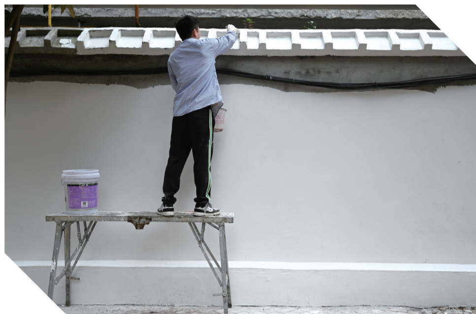
工人在潭中明园北园粉刷围墙。
