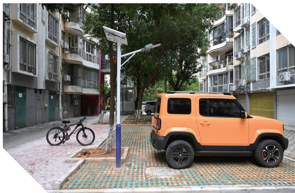
新建的生态停车位和新安装的路灯。
