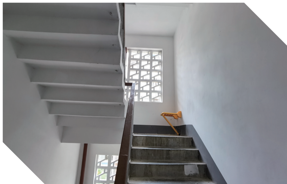
峨嵋小区内被粉刷一新的楼道。
