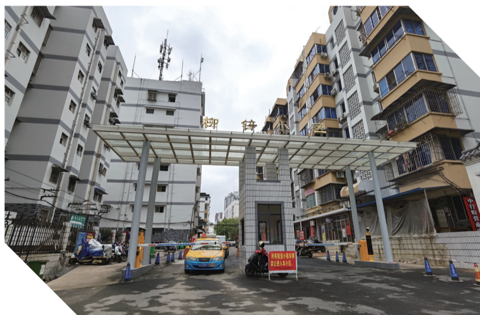
柳铧小区在老旧小区改造中新安装的大门和道闸。
