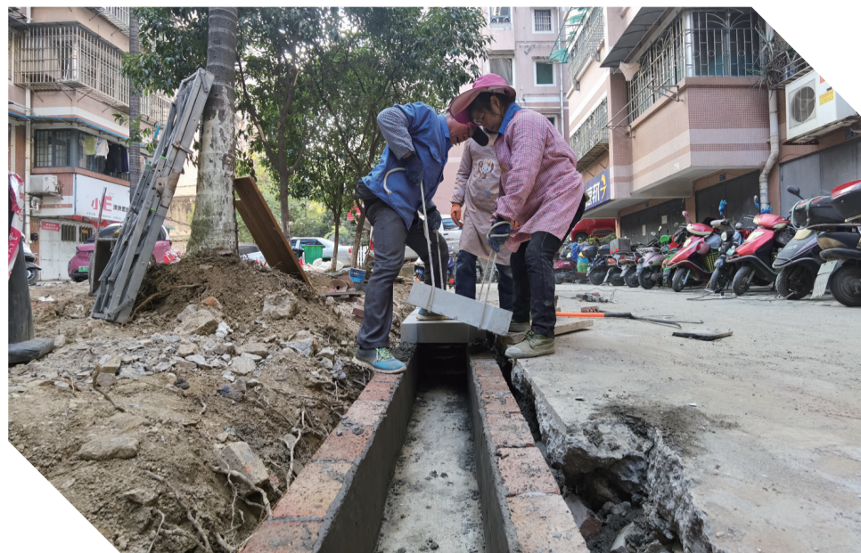
工人正在进行老旧小区改造施工。
