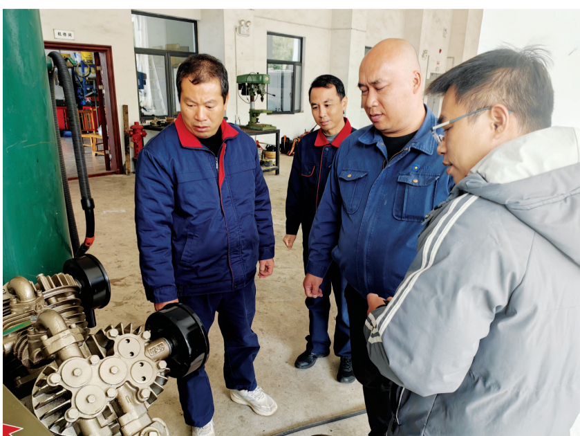
维修班工人交流设备维修经验。
