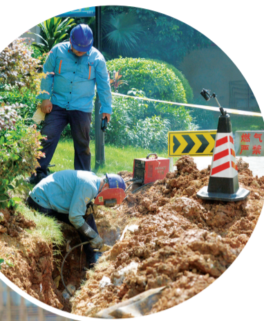
↑柳州中燃公司工作人员进行老旧管网改造。 ←工作人员检查储气罐。
