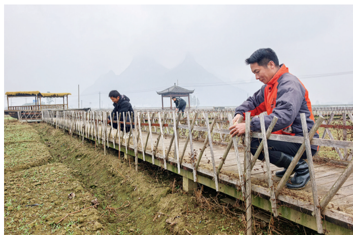
村民为观光栈道安装防护栅栏。
