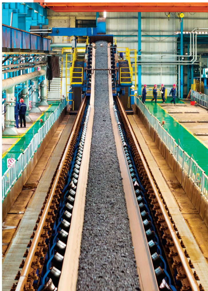
沿着长长的皮带管廊，铁矿石准备进入熔炉。
