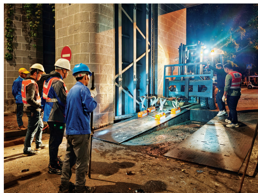
“防洪人”驾驶装载电磁铁的叉车,复位行车钢板。
