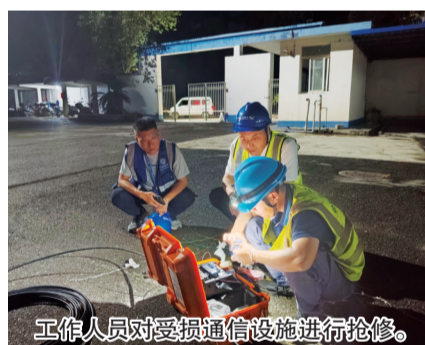
工作人员对受损通信设施进行抢修。
