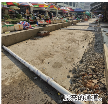
已铺设好的通道。
