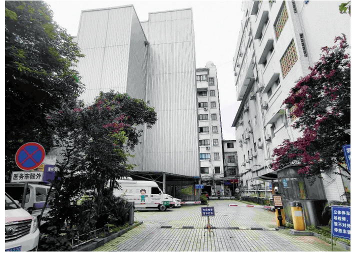
罗池路立体停车场南入口处门禁关闭。
